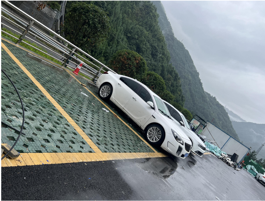
图2-3 项目区停车位硬化
